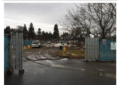
中庭部分に増床部分建築中
